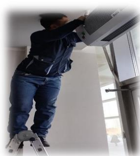
Зураг 36. ННЗТЦБ-ны халуун хөшгийг засварлаж буй байдал
