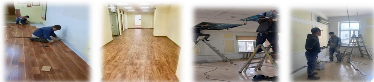
Зураг 29. Н33-ны 5В байрны нийтийн эзэмшилд засвар хийсэн байдал
