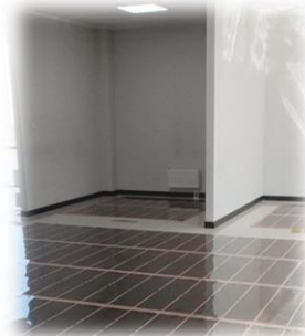
Зураг 34. ННЗТЦБ-ны техникийн өрөөнд плёнкон халаалт тавьсан байдал
