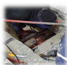
Зураг 15. НЗЗ-ны 5В байрны шугам хоолойг засварлаж буй явцаас
