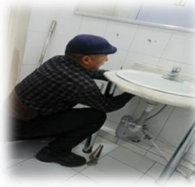
Зураг 18. Байруудын ариун цэврийн өрөөний угаалтуурын холигчийг шинэчилсэн
