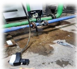
Зураг 14. НЗЗ-ны 3-р байрны ХХУ-ны хаалтыг шинэчилж буй явцаас
