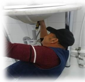
Зураг 18. Байруудын ариун цэврийн өрөөний угаалтуурын холигчийг шинэчилсэн
