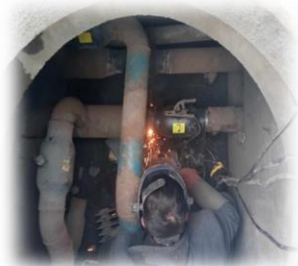
Зураг 19. НЗЗ-ны 3-р байрны хуучны ширмэн халаах хэрэгслийг шинэчилсэн
