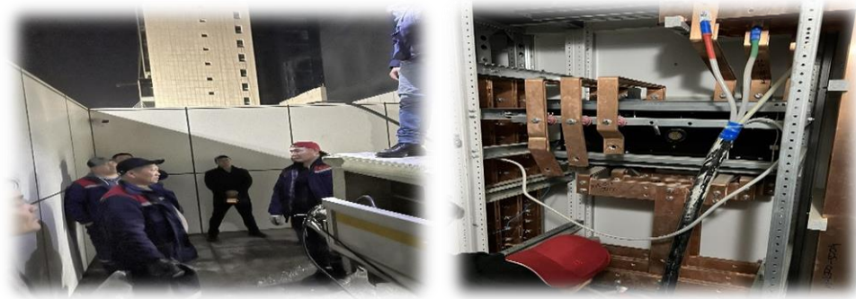
Зураг 13. Дизель генератор байршуулах үеэр
