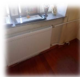
Зураг 20. НЗЗ-ны 5-р байрны дулааны ерөнхий магистрал шугам хоолойг шинэчилсэн
