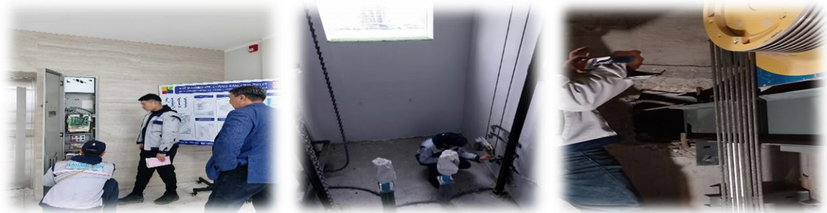
Зураг 23. Цахилгаан шатуудад засвар үйлчилгээ хийж буй явцаас
