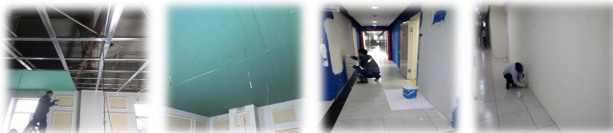
Зураг 27. Н33-ны 5В байрны дээврийн засвар хийсэн байдал
