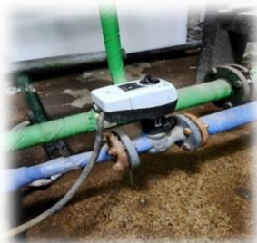
Зураг 14. НЗЗ-ны 3-р байрны ХХУ-ны хаалтыг шинэчилж буй явцаас
