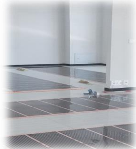
Зураг 34. ННЗТЦБ-ны техникийн өрөөнд плёнкон халаалт тавьсан байдал
