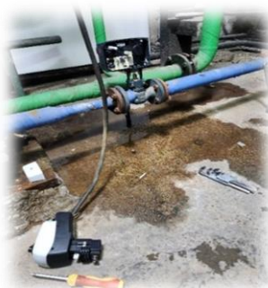
Зураг 7. НЗЗ-ны 3-р байрны ХХУ-ны хаалтыг шинэчилж буй явцаас
