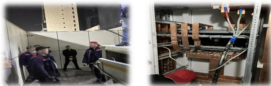
Зураг 6. Дизель генератор байршуулах үеэр
