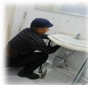
Зураг 11. Байруудын ариун цэврийн өрөөний угаалтуурын холигчийг шинэчилсэн
