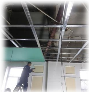
Зураг 15. НЗЗ-ны 5В байрны дээврийн засвар хийсэн байдал
