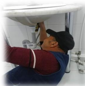
Зураг 11. Байруудын ариун цэврийн өрөөний угаалтуурын холигчийг шинэчилсэн
