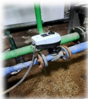
Зураг 7. НЗЗ-ны 3-р байрны ХХУ-ны хаалтыг шинэчилж буй явцаас
