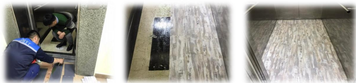
Зураг 28. Лифтний шалны хуучирсан хулдаасыг шинэчилсэн байдал
