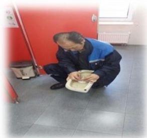
Зураг 19. Байруудын ариун цэврийн өрөөний угаалтуурын холигчийг шинэчилсэн
