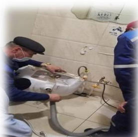
Зураг 18. Баянхошуу дэд төвийн АЦӨ-ний угаалтуурын холигчийг шинэчилсэн
