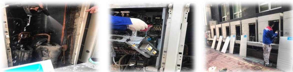
Зураг 29. Агааржуулалтын системийн горимыг схемд холбож буй явцаас
