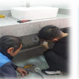
Зураг 19. Байруудын ариун цэврийн өрөөний угаалтуурын холигчийг шинэчилсэн
