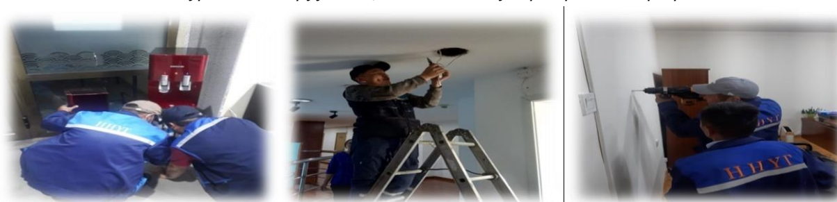
Зураг 12. Байруудын цахилгааны засвар үйлчилгээ хийгдэж буй явцаас
