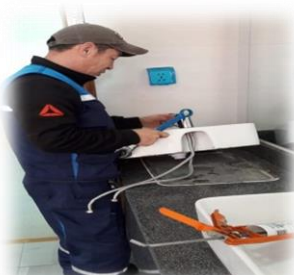
Зураг 18. Баянхошуу дэд төвийн АЦӨ-ний угаалтуурын холигчийг шинэчилсэн
