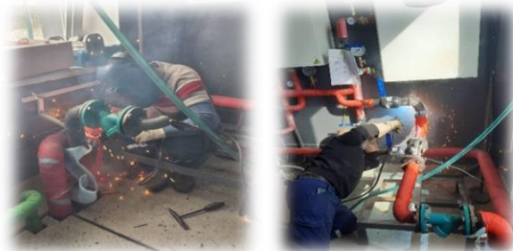
Зураг 22. Сэлбэ дэд төвийн дулааны тоолуурыг шинэчлэх явц
