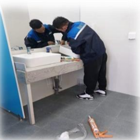
Зураг 19. Байруудын ариун цэврийн өрөөний угаалтуурын холигчийг шинэчилсэн
