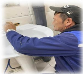
Зураг 21. 5-р байрны Б,В корпусын АЦӨ-ний угаалтуурын холигчийг засварласан
