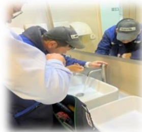
Зураг 21. 5-р байрны Б,В корпусын АЦӨ-ний угаалтуурын холигчийг засварласан
