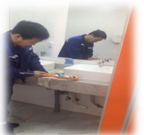
Зураг 19. Байруудын ариун цэврийн өрөөний угаалтуурын холигчийг шинэчилсэн
