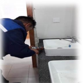
Зураг 18. Баянхошуу дэд төвийн АЦӨ-ний угаалтуурын холигчийг шинэчилсэн
