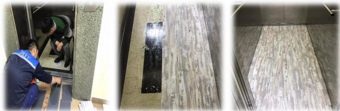
Зураг 16. Лифтний шалны хуучирсан хулдаасыг шинэчилсэн байдал
