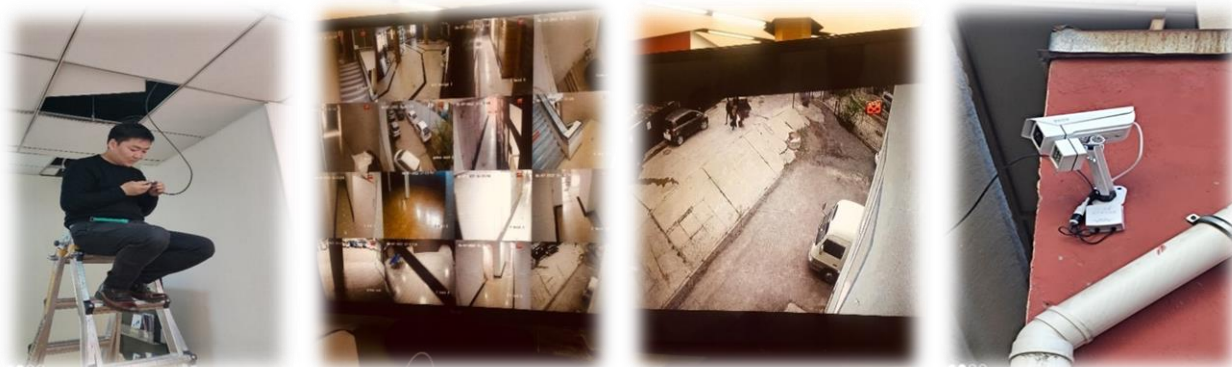
Зураг 13. Камер засвар үйлчилгээний явцаас
