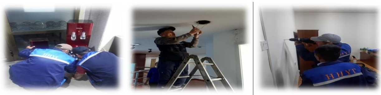
Зураг 8. Байруудын цахилгааны засвар үйлчилгээ хийгдэж буй явцаас
