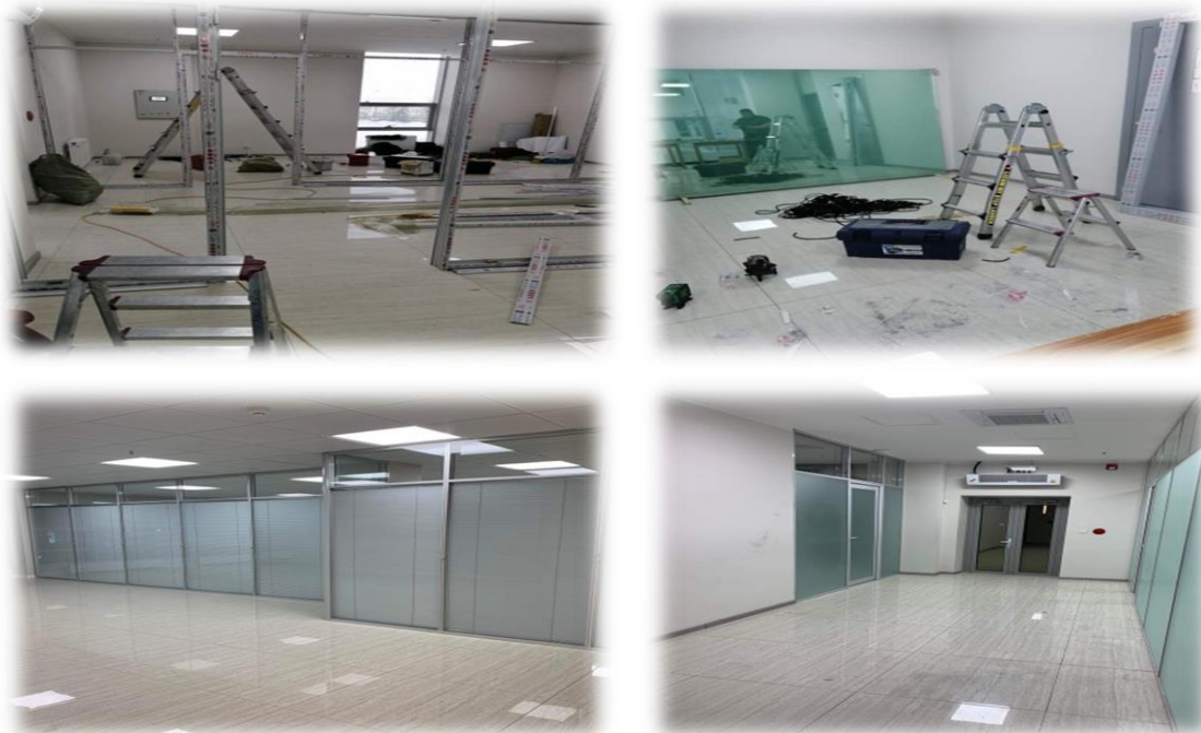
Зураг 22. Өрөөнүүдийг тусгаарлалт хийж бэлэн болгосон байдал
