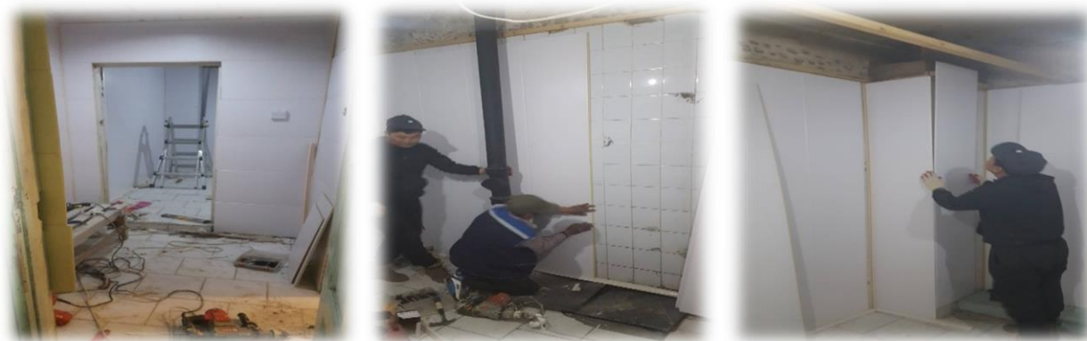
Зураг 18. Ариун цэврийн өрөөг шинэчлэн засварлаж буй үеэр
