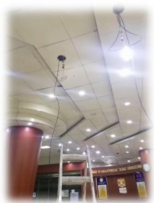
Зураг 34. НЗЗ-ны 4-р байранд 32 сувагтай NVR 2.5tb хард, 3тр нягтралтай камер шинээр суурилуулсан
