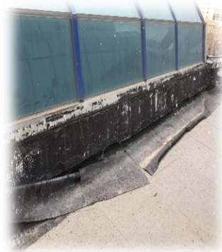
Зураг 43. НЗЗ-ны 4-р байрны 4 давхрын дээврийн хар цаас хууларсныг засварлав
