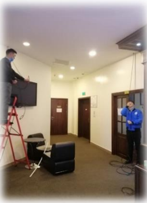
Зураг 32. Хангарди ордны хурлын заалны WGA кабелийг HDMI кабелаар сольсон байдал
