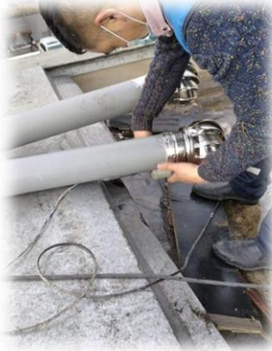
Зураг 23. 5Б корпуст өрөөний агааржуулалтын сэнсийг суурилуулсан
