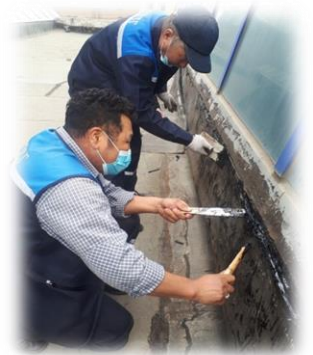
Зураг 43. НЗЗ-ны 4-р байрны 4 давхрын дээврийн хар цаас хууларсныг засварлав
