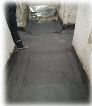
Зураг 44. НЗЗ-ны 5-р байрны В корпусын дээврийн хар цаас цоорсоныг засварлав
