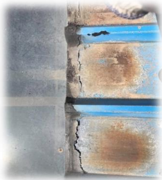
Зураг 42. НЗЗ-ны 2-р байрны 16 давхрын шилэн дээврийн засвар хийгдсэн байдал
