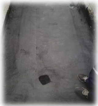
Зураг 44. НЗЗ-ны 5-р байрны В корпусын дээврийн хар цаас цоорсоныг засварлав
