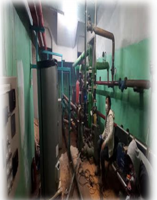
Зураг 27. Н33-ны 1-р байрны Цахилгаан бойлер шинэчлэн угсарч суурилуулж буй байдал
