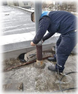
Зураг 23. 5Б корпуст өрөөний агааржуулалтын сэнсийг суурилуулсан
