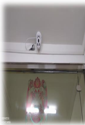
Зураг 33. НЗЗ-ны 3-р байранд NVR 3тр нягтралтай камер, 14инчтэй дэлгэц, 8 port свич зэргийг сольсон
