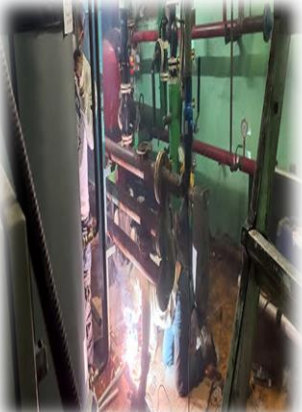
Зураг 27. Н33-ны 1-р байрны Цахилгаан бойлер шинэчлэн угсарч суурилуулж буй байдал
