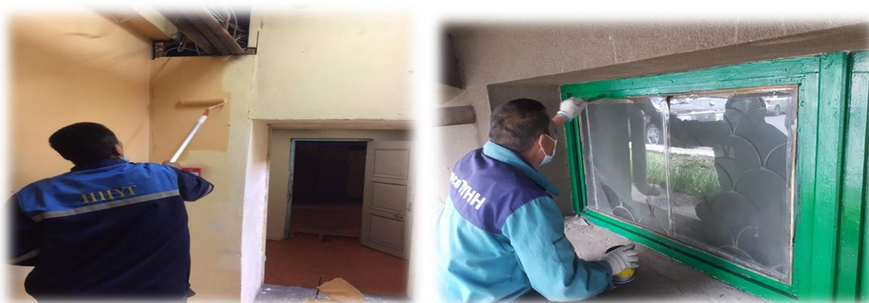
Зураг 31. НЗЗ-ны 4-р байрны нийтийн эзэмшлийн талбайг будаж засварлав
