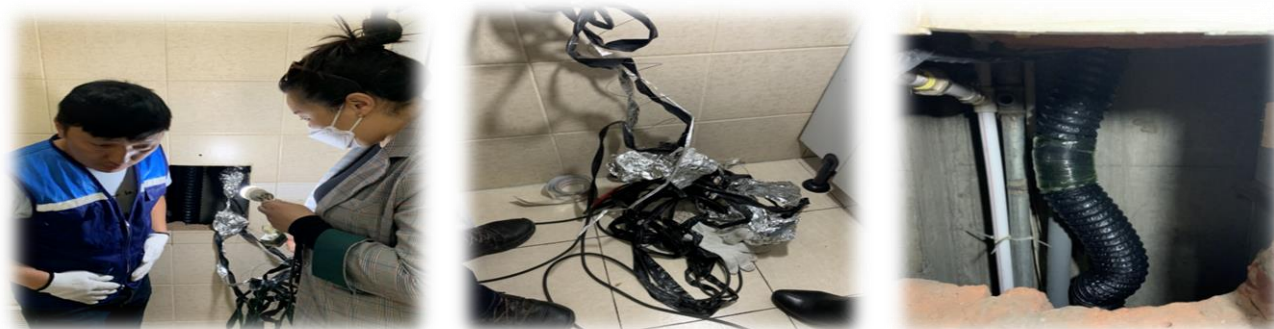
Зураг 15. НЗЗ-ны 2-р байрны цэвэр усны босоо шугам сольсон
