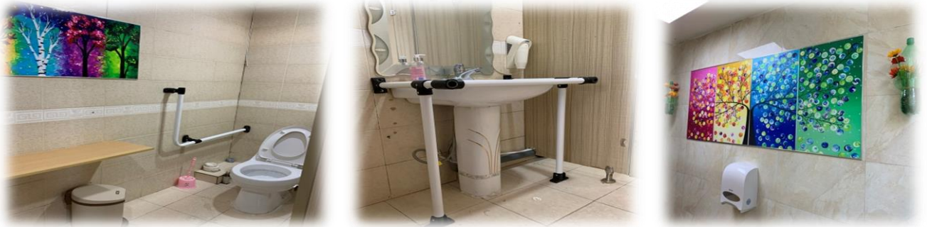
Зураг 49. Ариун цэврийн өрөөг тохижуулсан байдал
