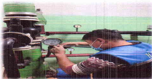
Зураг 22. НЗЗ-ны 1-р байрны халаалтын хэлхээн дээр манометр тавьж байгаа нь
