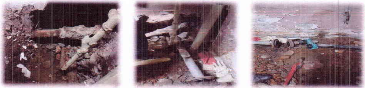
Зураг 31. НЗЗ-ны 3-р байрны халаалтын буцах шугамын засварын ажил
