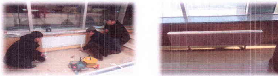
Зураг 27. НЗЗ-ны 2-р байрны 16 давхарт халаах хэрэгсэл шинээр суурилуулсан байдал
