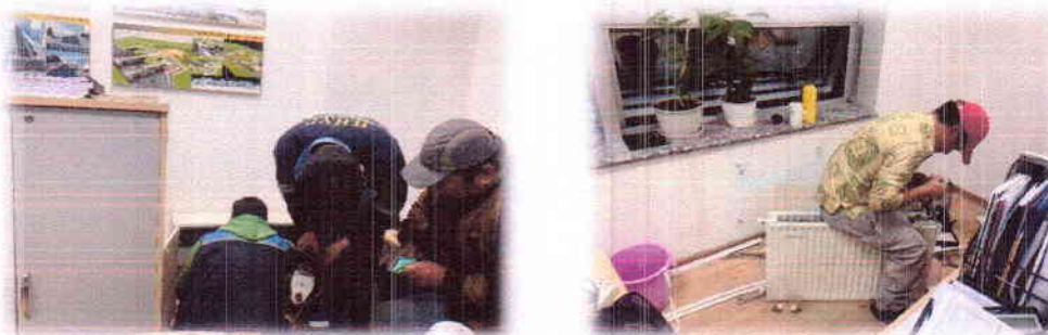
Зураг 26. НЗЗ-ны 2-р байрны 12 давхрын халаалтын цоорсон шугам хоолойг сольж байгаа нь
