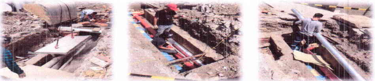
Зураг 33. НЗЗ-ны 5 дугаар байрны гадна шугам, хоолойн засвар
