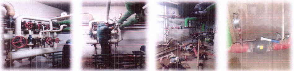
Зураг 32. НЗЗ-ны 4-р байрны халаалтын ерөнхий коллекторын хаалтыг шинэчилсэн нь
