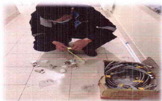
Зураг 18. Шугам хоолойн холбох хэрэгсэл, хаалт шинэчилж байгаа байдал
