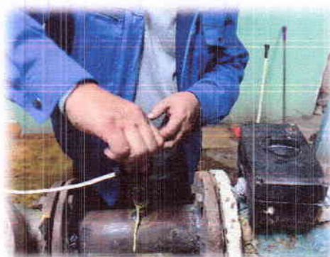
Зураг 21. НЗЗ-ны 1-р байрны хэрэгцээний усны автомат хаалтыг засаж байгаа нь
