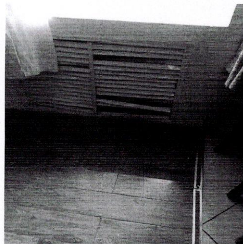
Зураг 4. Заалны цонхны халцарсан будаг, паарны хаалтны эвдэрсэн байдал
