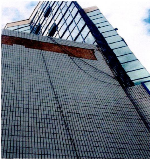
Зураг 14. Гадна фасад нурсан байдал
