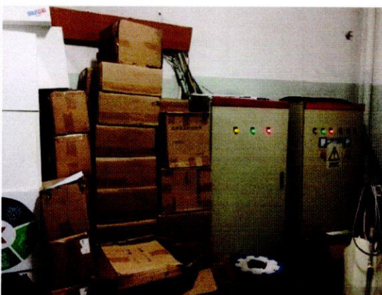
Зураг 2. Цахилгааны щитны өрөөнд эд зүйл хураасан байгаа нь
