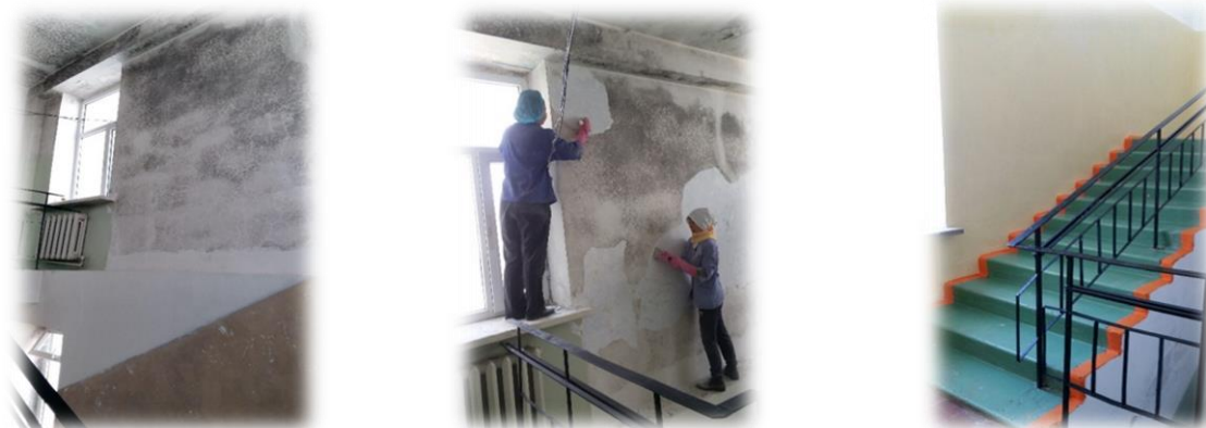
Зураг 44. НЗЗ-ны 5-р байрны А корпусын шатны засвар
