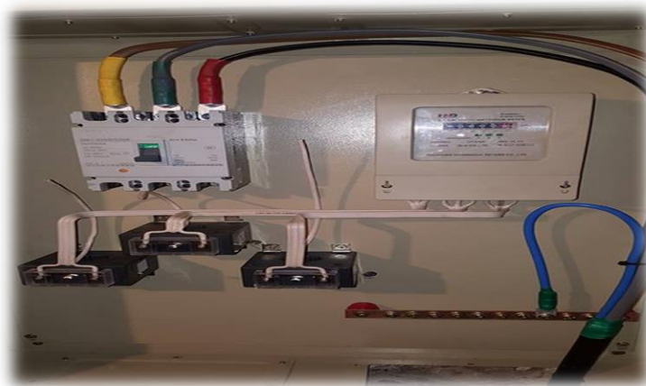
Зураг 30. 5 дугаар байранд шинээр тависан цахилгааны шитыг монтажилсан байдал
