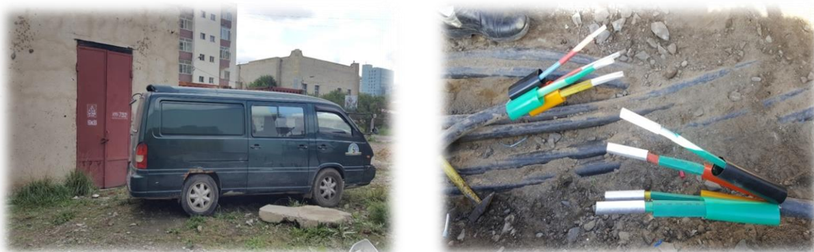
Зураг 29. Цахилгааны ерөнхий кабелийн шугамд гарсан гэмтлийг засварлаж буй байдал
