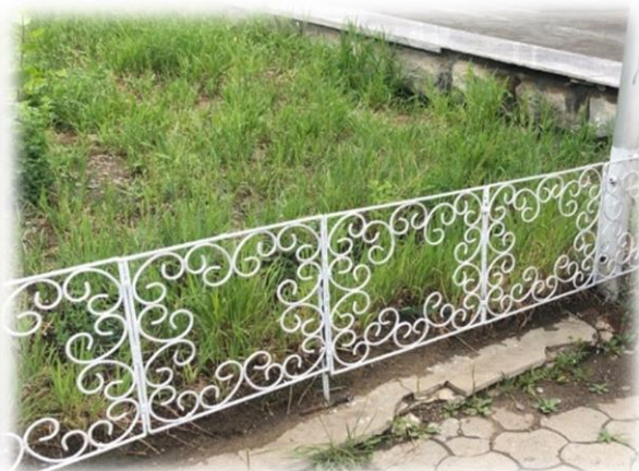
Зураг4. НЗЗ-ны 5В байрны гаднах хайсыг гэрлийн бүрхүүлийн хаягдал ашиглан хийв
