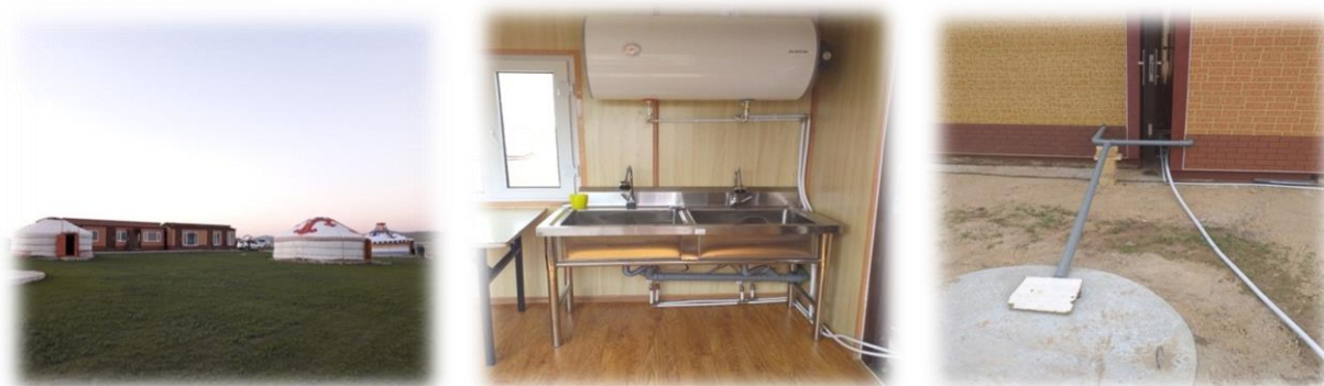
Зураг 41. Зөөврийн сууцанд халуун усны бойлер шинээр суурилуул байгаа байдал
