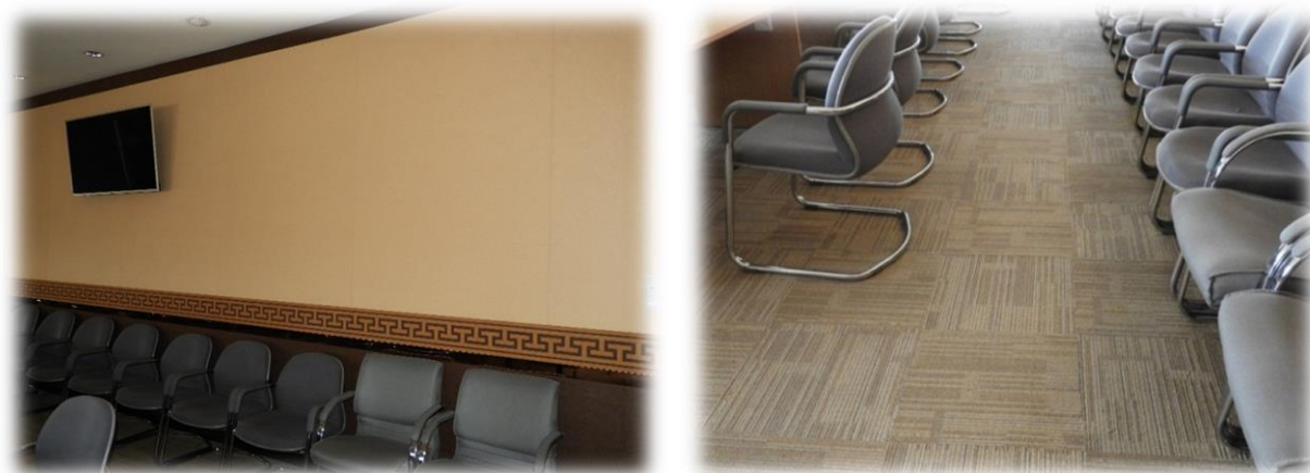
Зураг 52. Хурлын заалыг засварласан байдал
