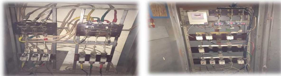
Зураг 40. Щитний оруулгыг шинэчлэн сольсон байдал
