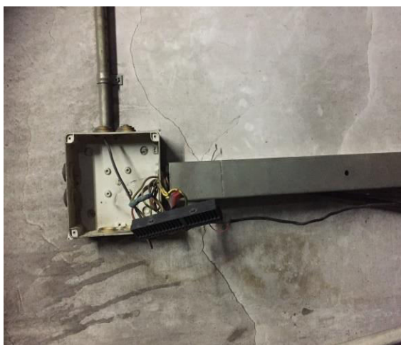
НЗЗ-ны 3 дугаар байрны подвал
