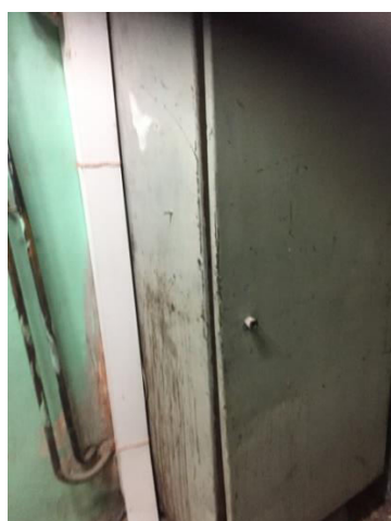
НЗЗ-ны 3 дугаар байрны подвал
